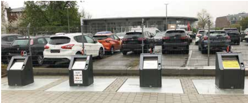
Das erste neue Unterflurcontainersystem in Lübeck wurde in der Waisenallee errichtet.
