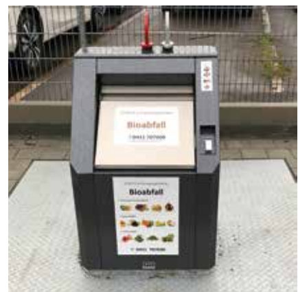
Die Einwurfschächte sind nur ca. 70 cm hoch. Schlösser verhindern Fremdnutzung.
